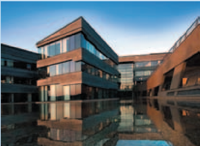
Central Premises of Telenor Távközlési Zrt.
