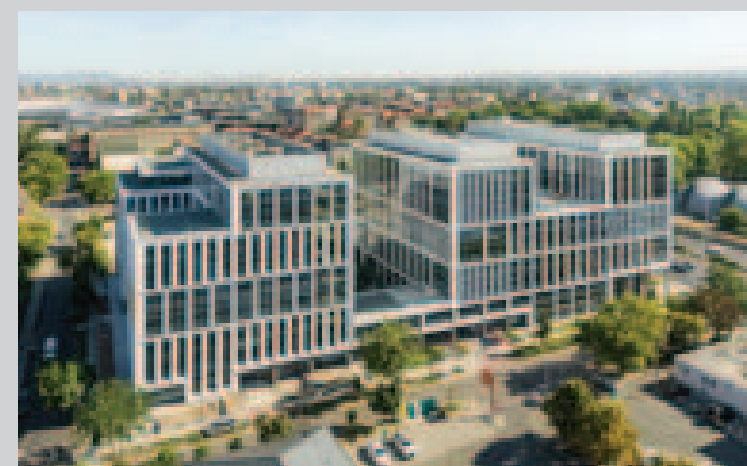
Aréna Business Campus A Épület, Budapest
